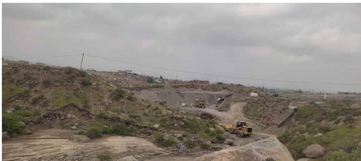
IMAGEN 02: SE MUESTRA LA COLMATACION LA QUEBRADA GAMARRA ASI COMO EN LA AP RTE BAJA EXISTE UNA CANTERA EN EL CAUCE DE LA QUEBRADA
